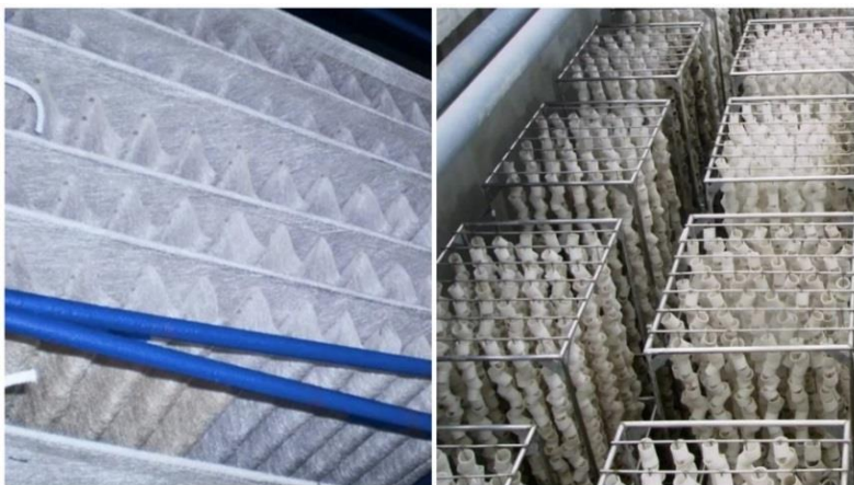
Рис. 2. Загрузочный материал: слева – плоскостная загрузка; справа – полимерная загрузка в виде полых цилиндров
