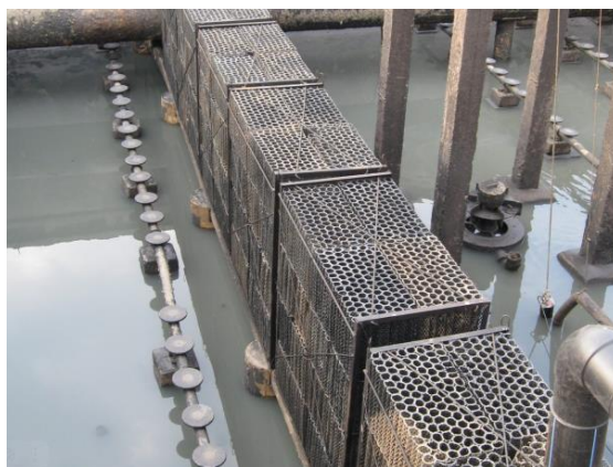
Рис. 1. Блочно-модульная кассета (объемная сетчатая биологическая загрузка)
