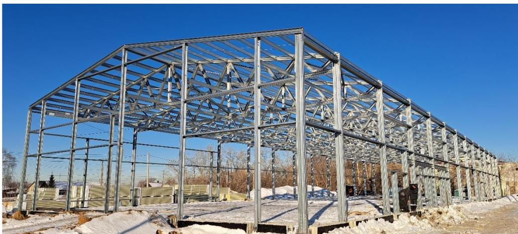
Рис. 1. Рамное здание производства ЛСТК-УРАЛ, г. Челябинск
