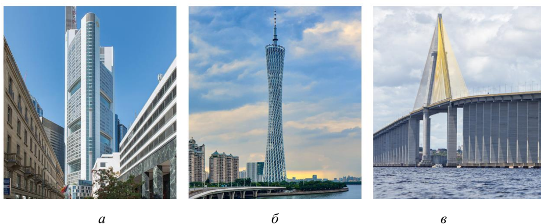
Рис. 1. Область применения трубобетонных конструкций в современном строительстве: а – офисное высотное здание “Commerzbank Tower”, г. Франкфурт, Германия; б – телебашня “Canton Tower”, г. Гуанчжоу, КНР; в – мост “Rio Negro Bridge” через р. Рио-Негро, Бразилия
