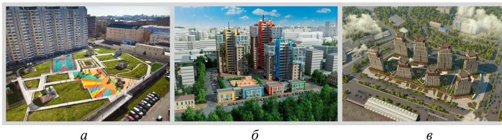
Рис. 2. Двор-сооружение (в т. ч. парковка): а – двор на 3-й Мытищинской улице, Алексеевский район, г. Москва, 2013 г.; б – ЖК «КМ ПРАЙМ», ул. Малая Ямская, д. 18, г. Нижний Новгород, компания «СС ПРОЕКТ», 2018 г.; в – ЖК «АТЛАНТ СИТИ», ул. Владимира Высоцкого, д. 1, г. Нижний Новгород, арх. бюро «5 и 5», 2018 г.
