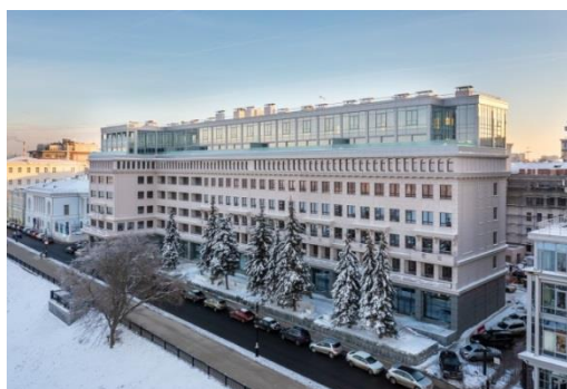
Рис. 6а. Воссозданный в 2022 г. объект – жилой дом ЖК «Георгиевский» (фото с сайта застройщика)
