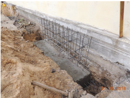
Рис. 14. Арматурные работы по устройству вертикальной стенки уширения ленточного фундамента «В/3-2»
