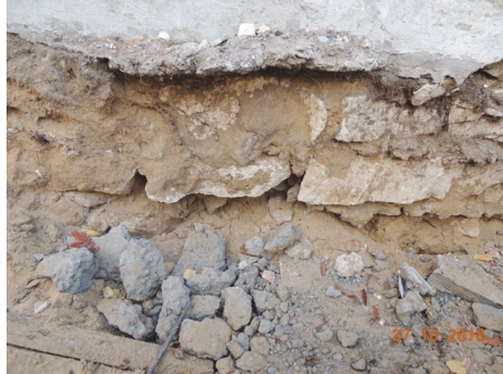
Рис. 11. Бутовая кладка вскрытого фрагмента фундамента без цементного раствора с частичным заполнением пустот между камнями грунтом. Камни легко извлекаются из кладки фундамента
