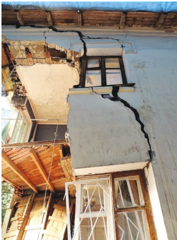
Рис. 5. Обрушение фрагмента торцевой стены, ориентированной по оси «11», и перекрытий. Несущие балки деревянных междуэтажного и чердачного перекрытий опираются на внутреннюю поперечную несущую стену толщиной в 250 мм и на внутреннюю несущую стенку-версту торцевой стены толщиной в 120 мм, ориентированной по оси «11» (то же на рис.7, 8 цв. вклейки)
