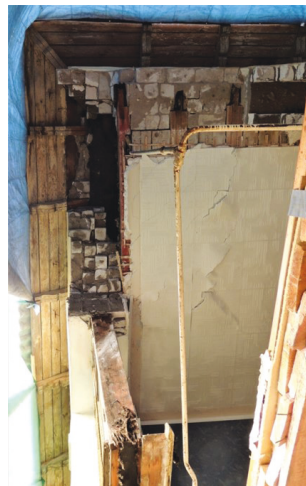
Рис. 6. Кладка наружных стен облегченная, колодцевая с засыпкой шлаком и забутовкой из половинок силикатного кирпича и по этой причине с наружной и внутренними верстами, не перевязанными между собой (то же на рис. 7, 8 цв. вклейки)
