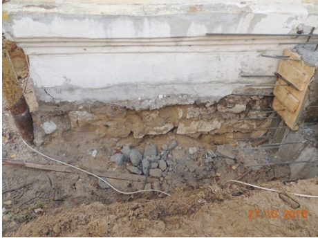
Рис. 10. Бутовый фундамент торцевой стены на участке в осях «1/В-Б». Глубина заложения от уровня планировки участка не превышает 0,6 м (см. рис. 11 цв. вклейки)
