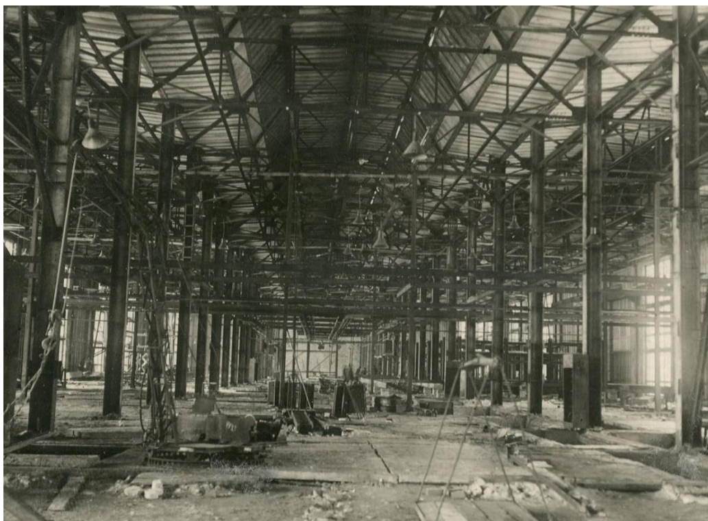
Рис. 1. Строительство корпусов завода № 122. Вид на кровлю из металлического настила по фермам. Источник: ЦГАСО. Ф. Р-3985, оп. 2, д. 10, л. 89
