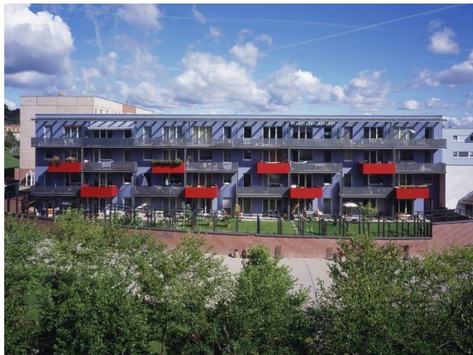
Рис. 5. Уменьшение высоты крупнопанельного здания в г. Лайнефельде, Германия, 2002 г.
