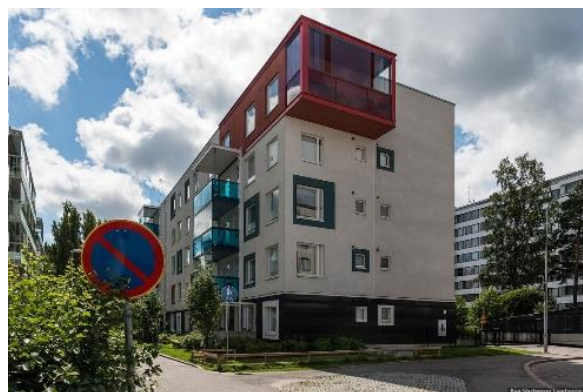
Рис. 10. Надстройка здания и включение в архитектурно-пластическое решение балконов
