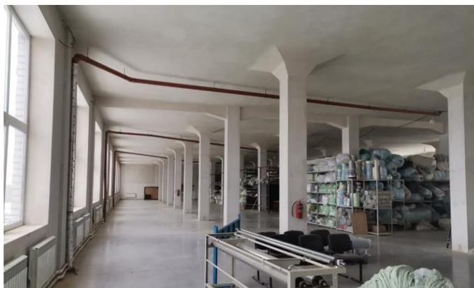
Рис. 5. Интерьер боенско-утилизационного блока с безбалочными межэтажными перекрытиями
