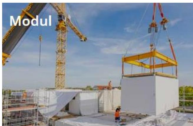
Рис. 1. Монтаж готового блока многоэтажного жилого дома
