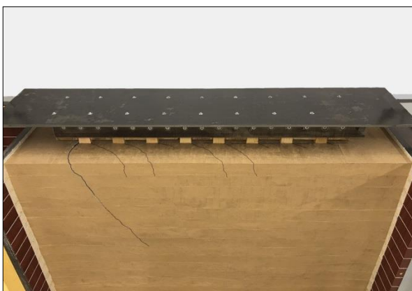
Рис. 6. Трещины на поверхности массива грунта при горизонтальном перемещении диафрагмы из 8 свай \Delta_r=4 мм и работы 5 последних свай на выдергивание
