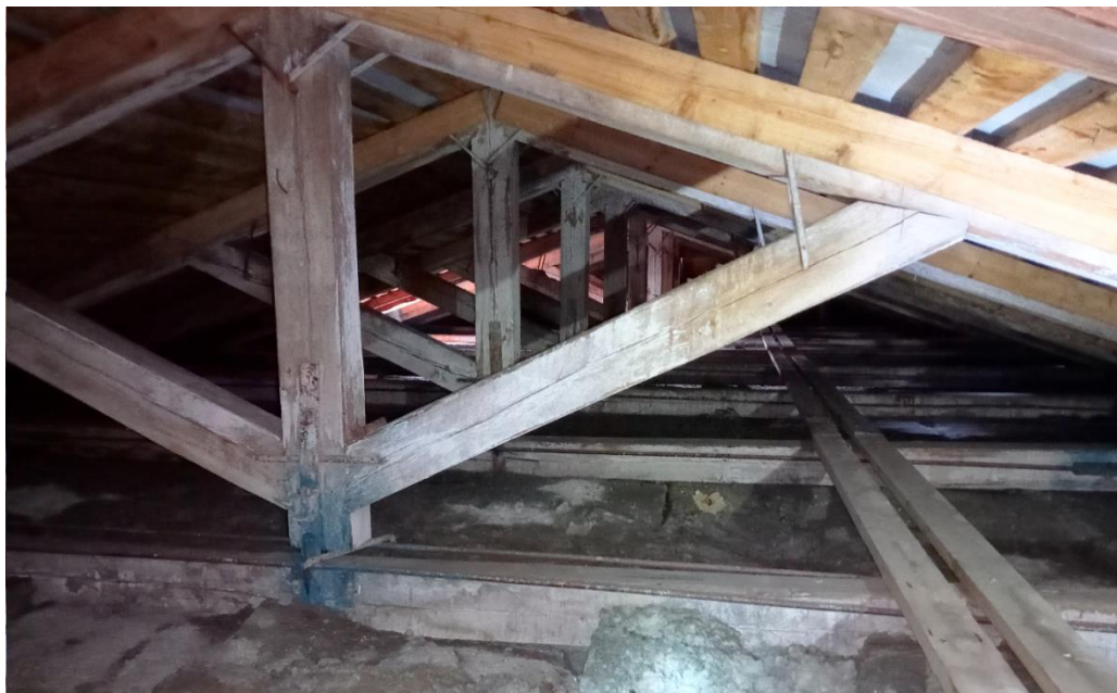
Рис. 1. Ферма деревянной стропильной системы с одной бабкой. Научная библиотека ТГУ, I объём. Фото Кутукова А., июль 2024 г.
