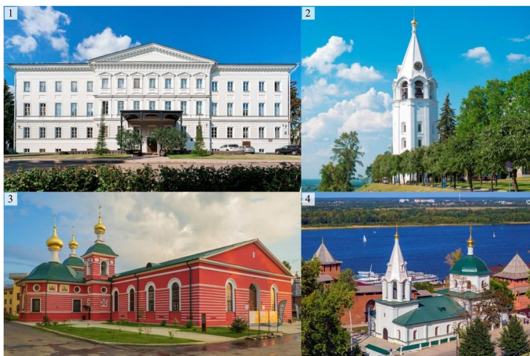
Рис. 2. Объекты культурного наследия после проведения реставрационных работ. Фото 2021 г.: 1. Дом военного губернатора. 2. Колокольня Спасо-Преображенского собора. 3. Здание Манежа с домовою Никольской церковью. 4. Храм Симеона Столпника
