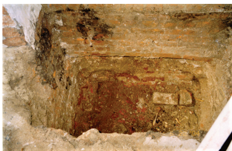
Рис. 10. Шурф № 17. Сторожка. Прямо: стена, ориентированная по оси «Б»; слева – стена по оси «2». Через несколько дней после вскрытия фундаментов на дне шурфа появилась грунтовая вода
