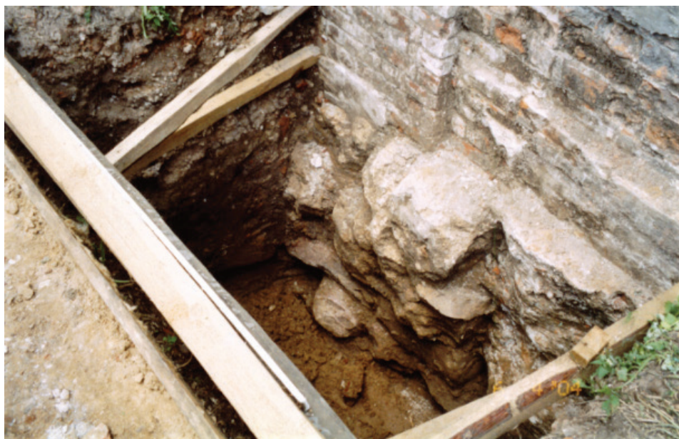
Рис. 3. Шурф № 4. Фундамент из бутового камня на глиняном растворе под южной стеной четверика церкви
