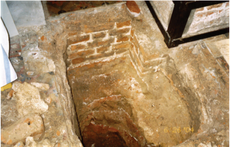
Рис. 5. Шурф № 5. Фундамент под кирпичным столбом четверика. Верхняя часть фундамента высотой 0,7 м – из глиняного кирпича на известковом растворе. Нижняя часть фундамента – из рваного бутового камня на глинистом растворе
