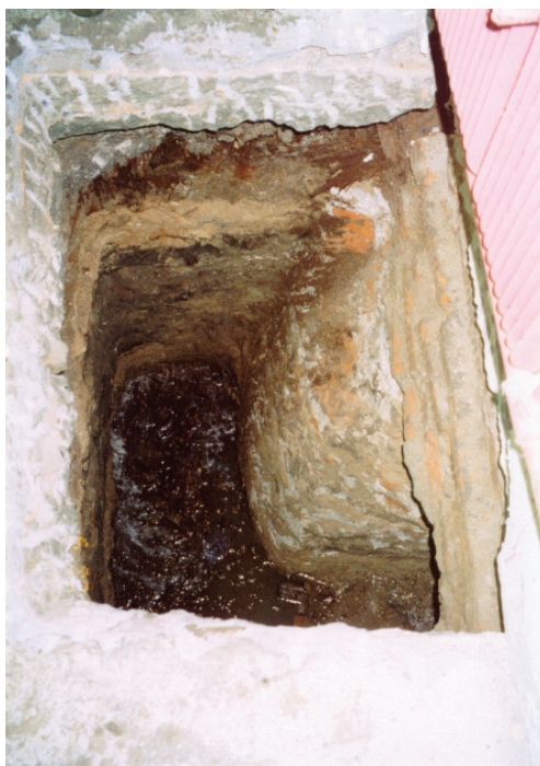
Рис. 8. Колокольня. Шурф № 12. Фундаменты на пересечении осей «Г/3». Нижняя часть фундамента – из бутового камня на известковом растворе. Верхняя часть на глубину 0,66 м от уровня пола – из глиняного кирпича на известковом растворе
