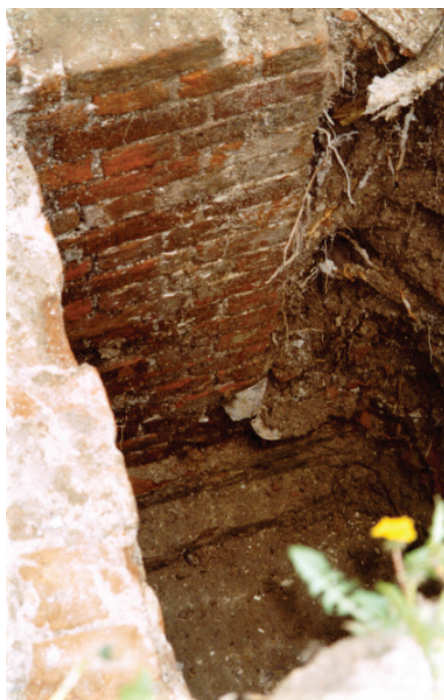
Рис. 7. Шурф № 19. Кладка контрфорса, как и подпорной стенки, выполнена из глиняного кирпича на известковом растворе
