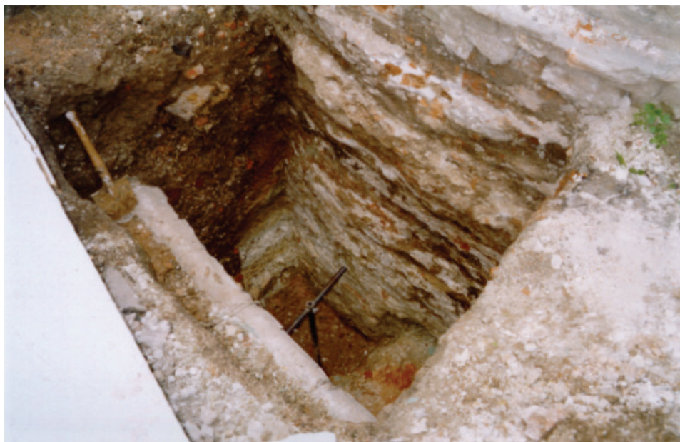
Рис. 2. Алтарь. Шурф 3. Фундамент с уступом (см. рис. 30, 31) выполнен из глиняного кирпича на известковом растворе
