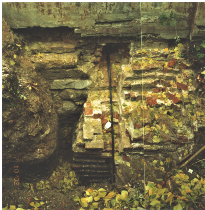
Рис. 4. Шурф 9 у северной стены четверика. Слева: фрагмент фундамента четверика, выполненного из постелистого бутового камня на известковом растворе. Справа: фрагменты ограждающих конструкций торговых лавок, разобранных во 30-х годах XX века и скрытых под искусственно отсыпанным грунтовым откосом
