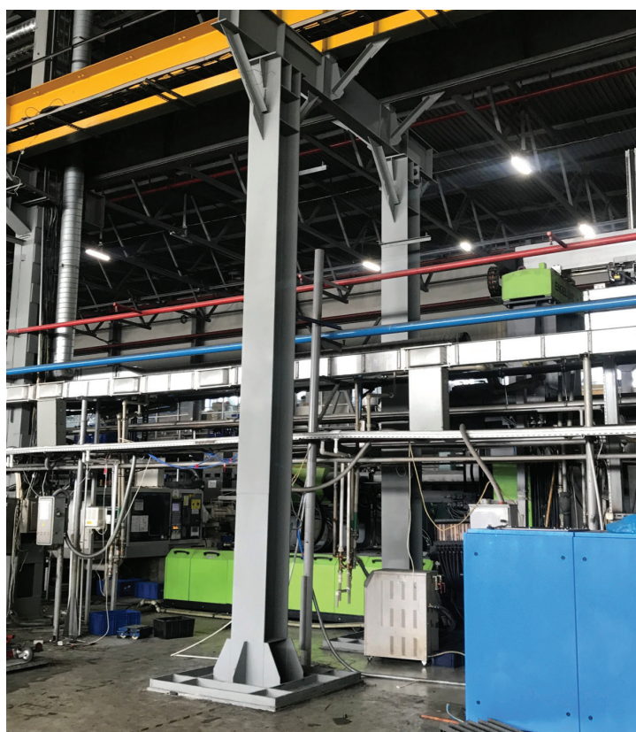
Рис. 1. Реализованный проект усиления подкрановых балок пролетом 12 м по ряду «Д»
