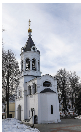
Рис. 3. Колокольня с церковью Александра Невского, арх. А. Н. Трофимов, 2006 г.
