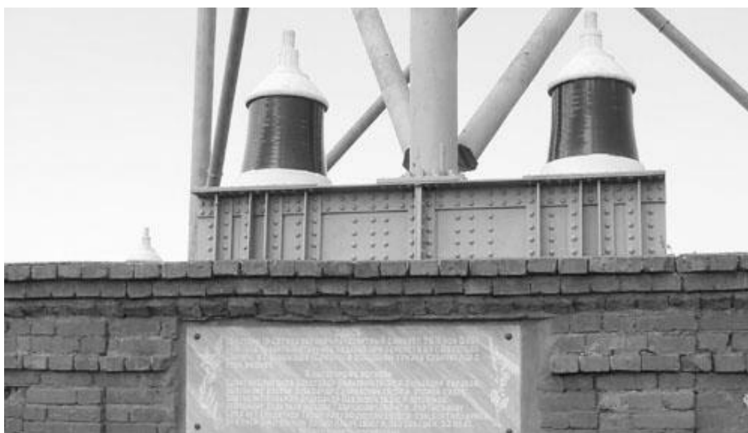
Рис. 4. Фарфоровый цилиндрический изолятор антенны (состояние на 2008 г.). Источник: http://rfanat.ru/s16/istoria1.html
