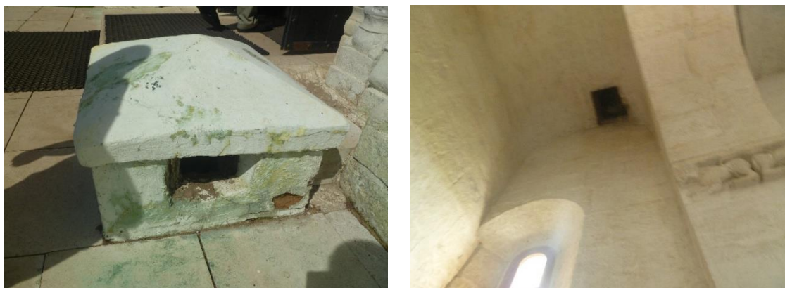
Рис. 3. Слева: оголовок вентиляционного канала над фундаментом церкви Покрова на Нерли; справа: вентиляционный канал в верхнем ярусе храма
