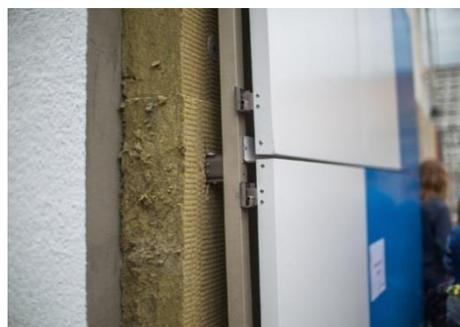
Рис. 2. Стеновая панель с вентилируемым фасадом
