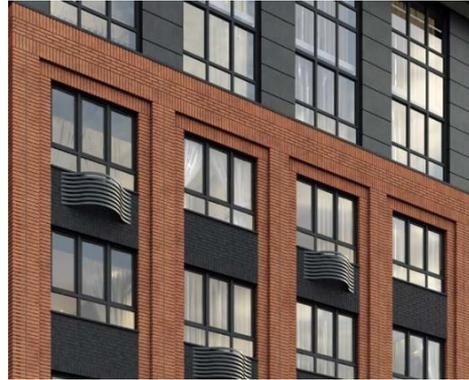
Рис. 13. Наружные стены из многослойных панелей.
