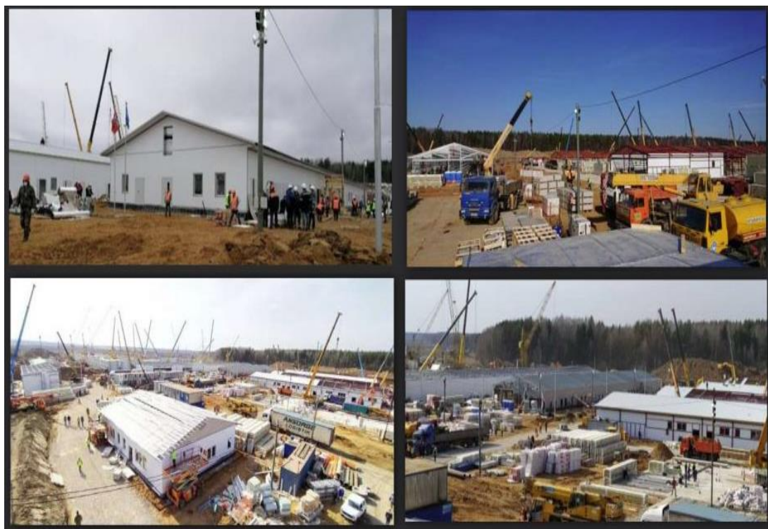
Рис. 4. Строительство многофункционального инфекционного центра по технологии ЛСТК
