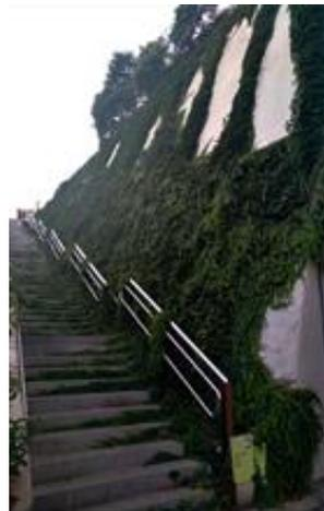
Рис. 13. Стены откосов виадука, заросшие плющом (фото 07.2023 г.)
