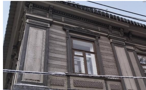
Рис. 10. Дом В. М. Лемке (ул. Короленко, 11). Детали фасада
