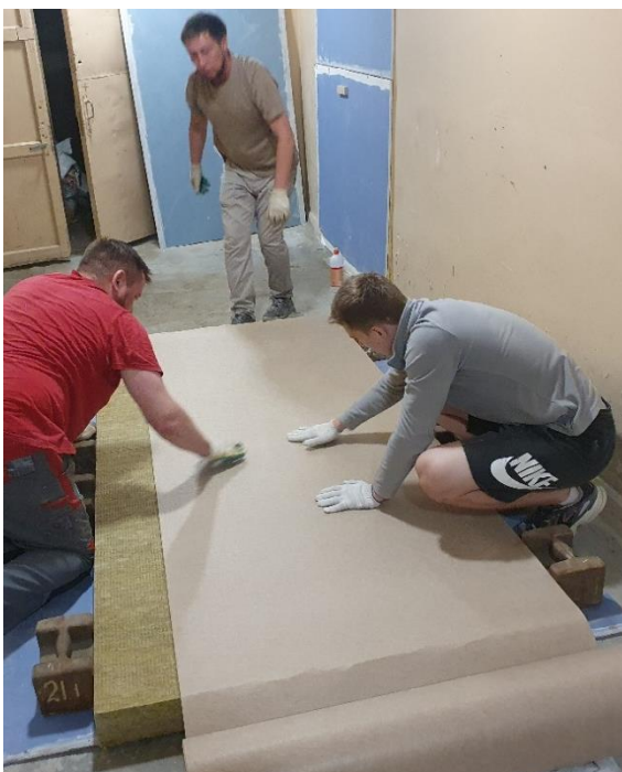
Рис. 2. Изготовление среднего слоя многослойной перегородки: а – на маты из жесткой минеральной ваты приклеивается упругий материал (маты полиэфирного волокна), обеспечивающий акустическое разобщение среднего слоя и торкрет-облицовок; б – средний слой установлен между двумя помещениями, на лицевую поверхность упругого материала приклеиваются формообразующие решетки, обеспечивающие фрагментацию торкрет-облицовок
