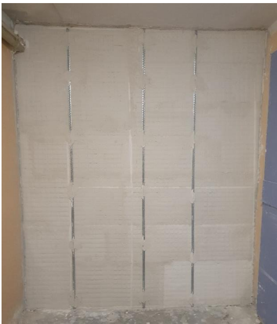
Рис. 5. Нанесение финишного слоя торкрет-смеси с выравниванием поверхности по вертикальным маякам
