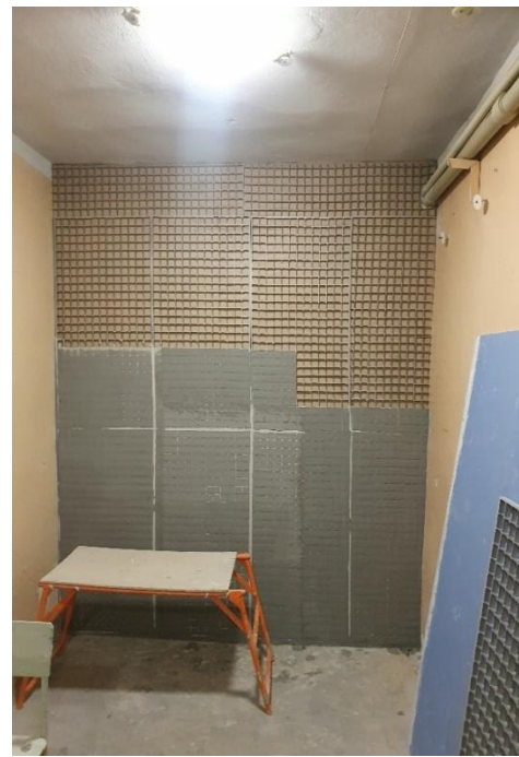
Рис. 4. Заполнение торкрет-смесью ячеек формообразующих решеток
