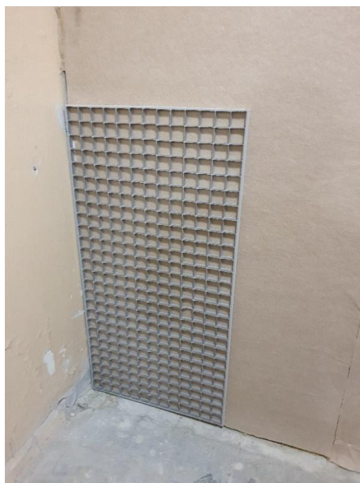
Рис. 2. Изготовление среднего слоя многослойной перегородки: а – на маты из жесткой минеральной ваты приклеивается упругий материал (маты полиэфирного волокна), обеспечивающий акустическое разобщение среднего слоя и торкрет-облицовок; б – средний слой установлен между двумя помещениями, на лицевую поверхность упругого материала приклеиваются формообразующие решетки, обеспечивающие фрагментацию торкрет-облицовок
