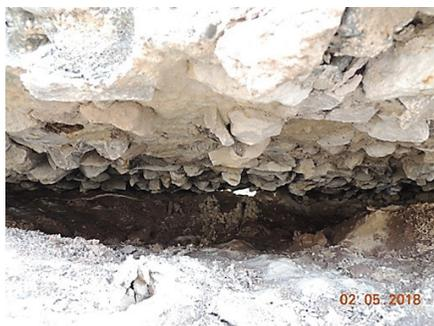
Рис. 13. Зазор величиной до 20 см между подошвой фундаментной плиты и грунтовым основанием (см. рис. 11)
