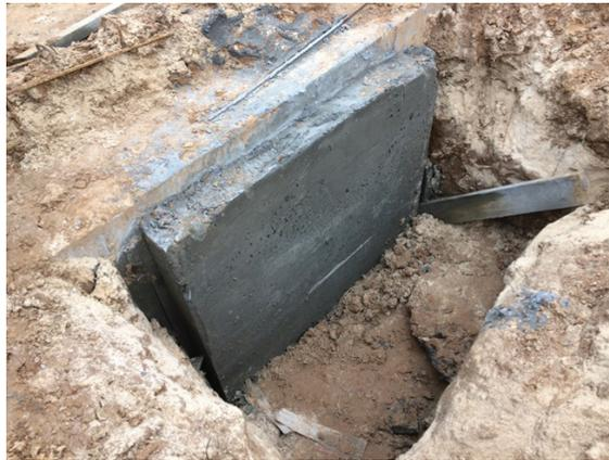
Рис. 17. Массив из цементного раствора, заместивший слабое основание под фундаментной плитой на захватке № 188
