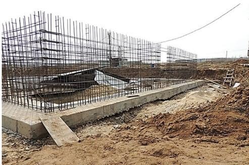
Рис. 12. Плитная часть фундамента Вымывание песка и щебня. Просадка лессового суглинка под фундаментной плитой на участке в осях «29/А-Е»
