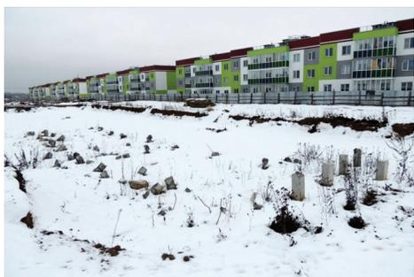
Рис. 2. Котлован, открытый с 12.2014 г. по 02.2018 г. Грунтовое основание в течение 3 лет подвергалось интенсивному замачиванию и промерзанию
