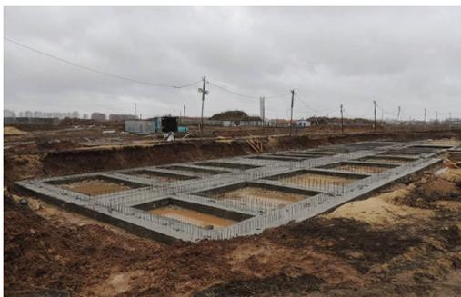
Рис. 8. 22 апреля 2018 г. Открытый котлован с плитной частью фундаментов, заполненный талой и дождевой водой
