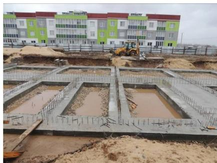
Рис. 9. Участок котлована в осях «15-29» с дождевой и талой водой
