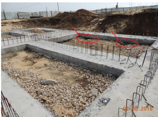
Рис. 10. Вымывание песка, щебня и насыщенного водой лессового суглинка из-под фундаментной плиты на участке в осях «1/Е-А»
