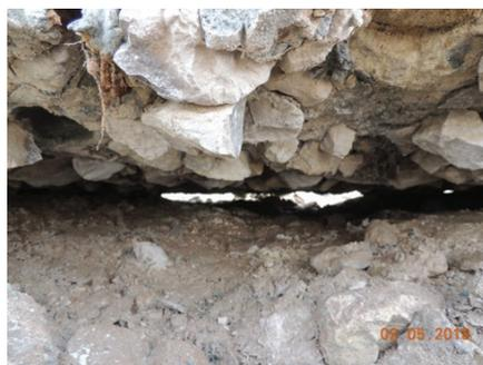
Рис. 11. Отрыв грунтового основания на 20 см от подошвы плитной части фундамента с втопленным в нее щебнем (см. рис. 9)
