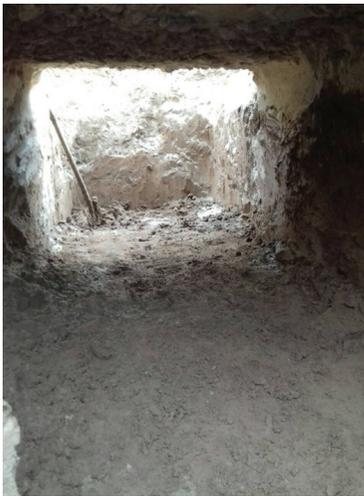
Рис. 16. Выборка слабого грунта из-под фундаментной плиты на захватке № 188
