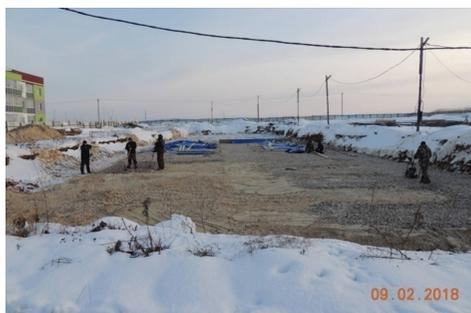
Рис. 3. 09 февраля 2018 г. Выполнены работы: 1) по зачистке дна котлована; 2) по устройству песчаной подсыпки. Ведутся работы по уплотнению подсыпки щебнем
