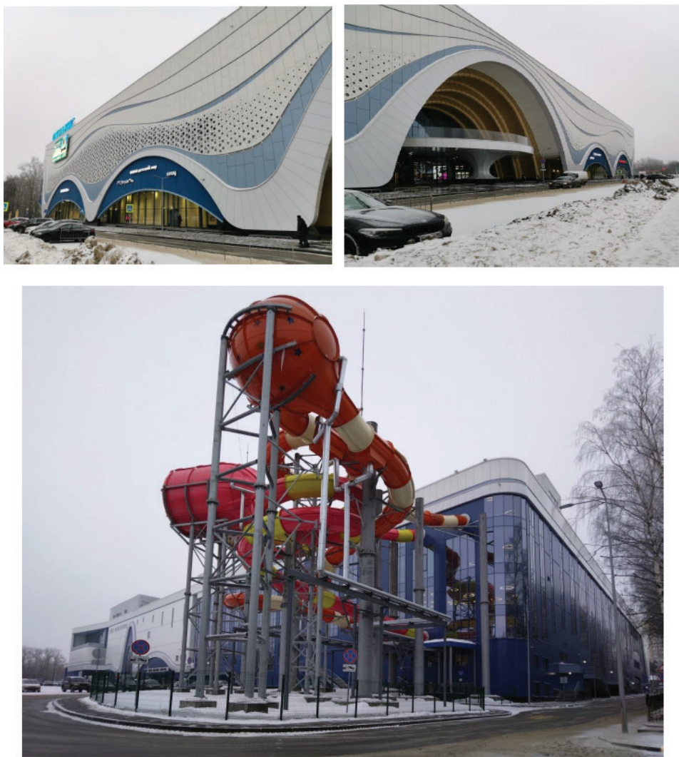
Рис. 1. Многофункциональный комплекс «Океанис». Вид с пр. Гагарина (фото М. Дуцева, 2023). Вид со стороны Оки (фото А. Гельфонд, 2023)
