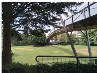
Рис. 17. Участок 2. Сад Рейи. Мост над поляной
