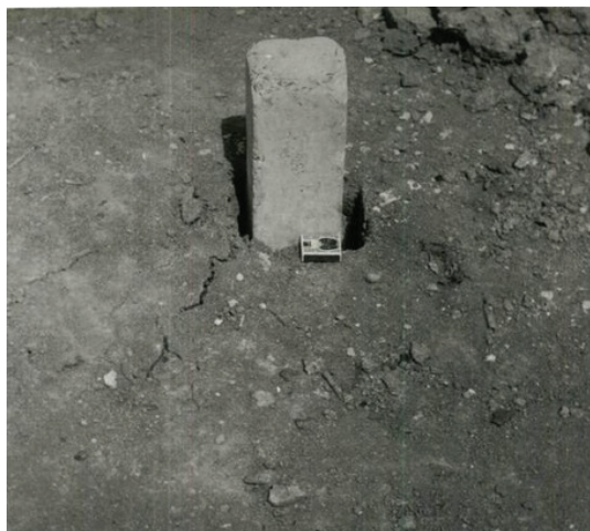
Рис. 2. Железобетонная свая длиной 2,75 м, сечением 120×120 мм, в суглинках твердой консистенции. В результате испытаний горизонтальной нагрузкой между задней (тыльной) частью боковой поверхности сваи и грунтом образовался зазор в 50 мм (отрыв сваи от грунта) [4]
