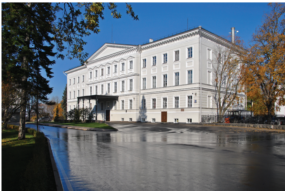
Рис. 1. Реставрация и приспособление для современного использования Дома военного губернатора (Нижегородский Кремль, корпус 3). Фото 2021 г.
