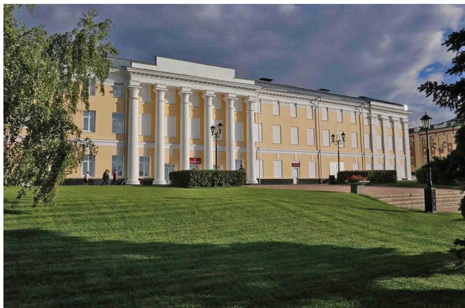
Рис. 3. Здание Присутственных мест – Нижегородская государственная филармония (Нижегородский кремль, корпус 2). Фото 2021 г.
