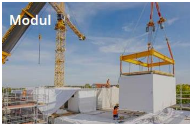
Рис. 1. Монтаж готового блока многоэтажного жилого дома [ https://max-boegl.de/leistungsbereiche/wohnen ]
