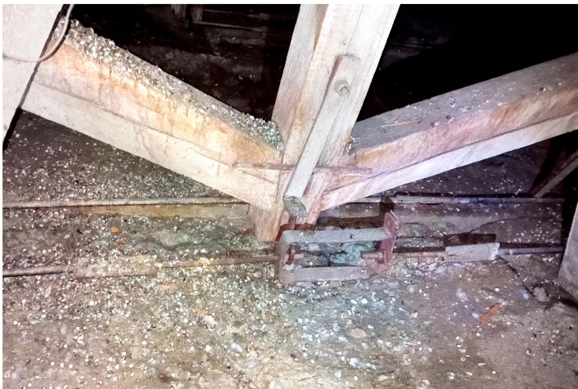
Рис. 6. Металлическая затяжка с резьбовой муфтой и крючкообразным подвесом. Научная библиотека ТГУ, III объем. Фото Кутукова А., июль 2024 г.
