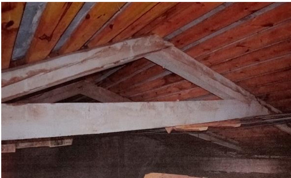
Рис. 4. Ферма деревянной стропильной системы с ригелем. Научная библиотека ТГУ, II объем. Фото Кутукова А., июль 2024 г.
