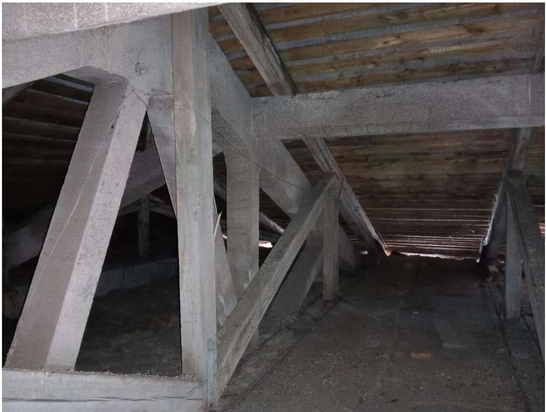
Рис. 9. Соединение железобетонных ферм прогоном. Научная библиотека ТГУ, III объём. Фото Кутукова А., июль 2024 г.
