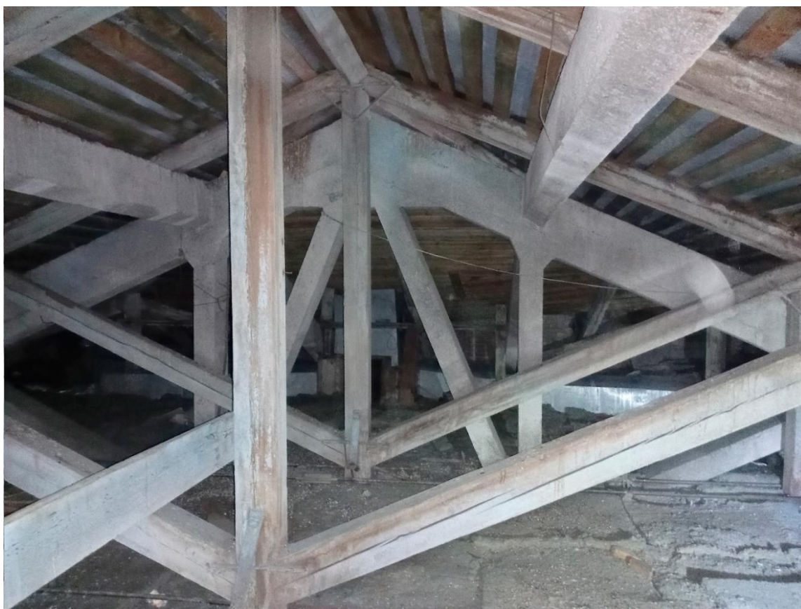
Рис. 7. Железобетонная ферма в чердачном пространстве (дальний план). Научная библиотека ТГУ, III объем. Фото Кутукова А., июль 2024 г.
