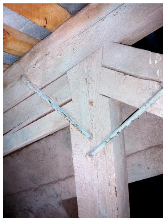
Рис. 3. Усиление металлическими скобами узлов стропильной системы библиотеки ТГУ. Фото Кутукова А., июль 2024 г.
