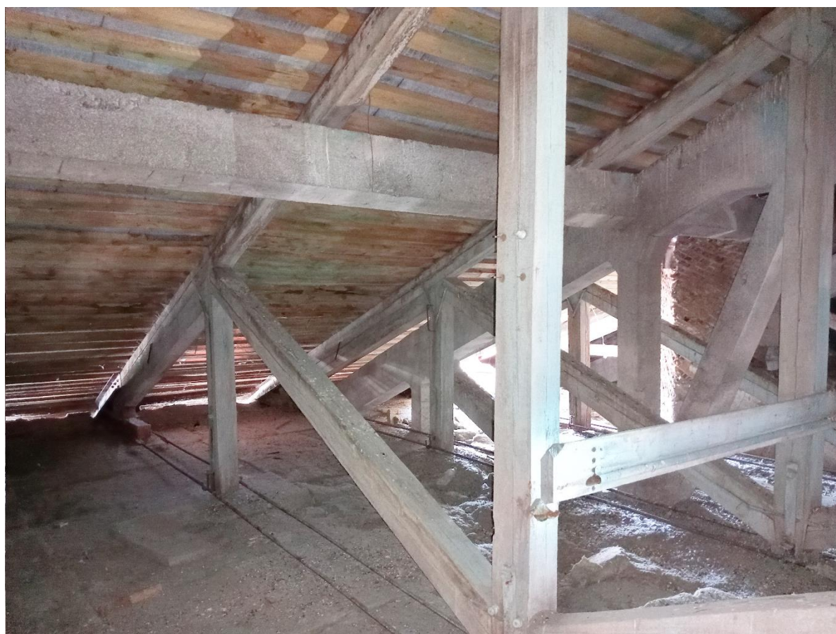
Рис. 5. Ферма деревянной стропильной системы с тремя бабками (передний план). Научная библиотека ТГУ, III объем. Фото Кутукова А., июль 2024 г.
