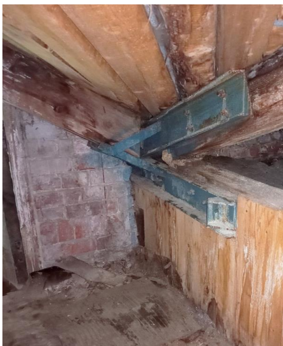
Рис. 2. Усиление узла стропильной системы библиотеки ТГУ металлическим швеллером. Фото Кутукова А., июль 2024 г.
