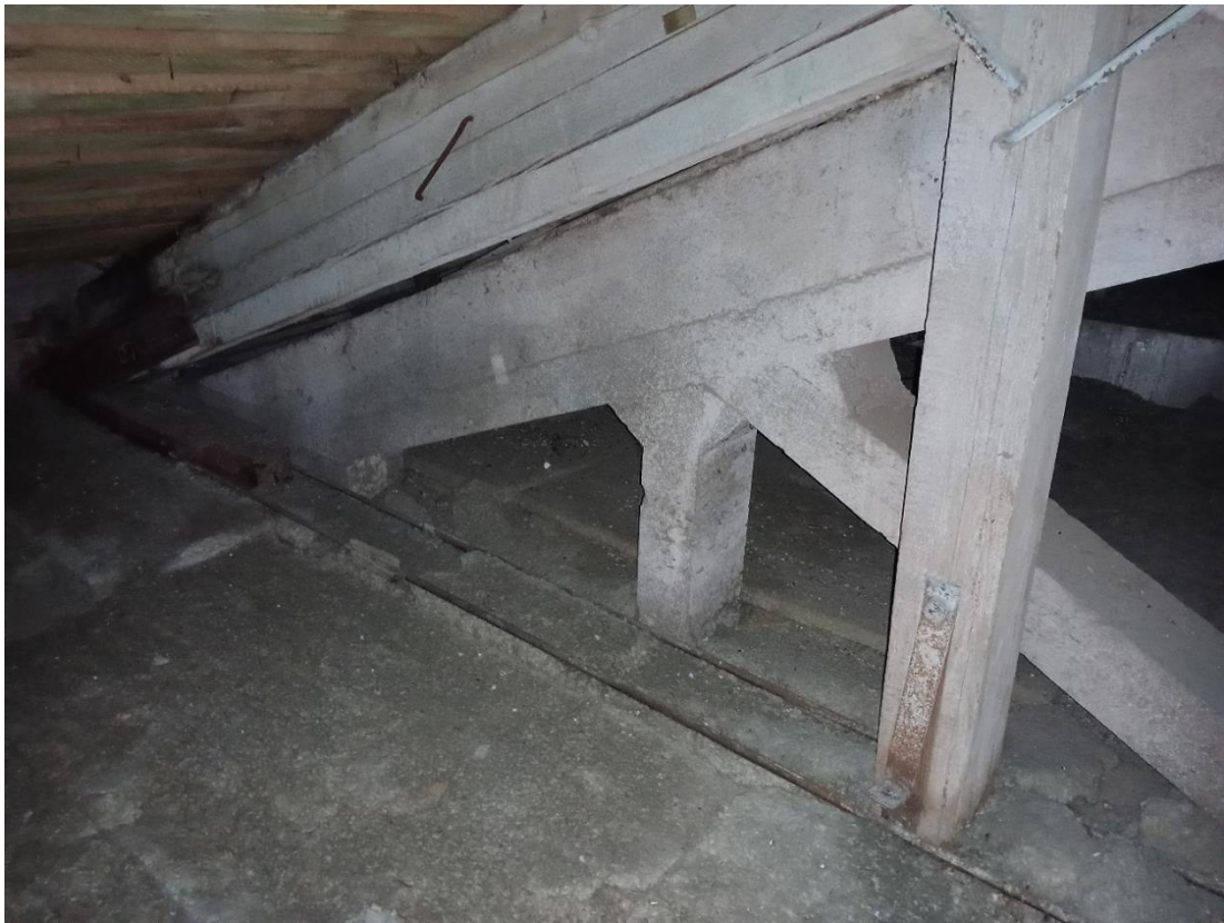
Рис. 8. Сочетание железобетонной и деревянной ферм. Научная библиотека ТГУ, III объём. Фото Кутукова А., июль 2024 г.
