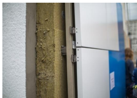
Рис. 2. Стеновая панель с вентилируемым фасадом [http://moscowwalks.ru/2017/06/02/kak-delayut-paneli/]
