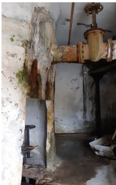
Рис. 3. Ввод воды в распределительные камеры на ВОС-1
