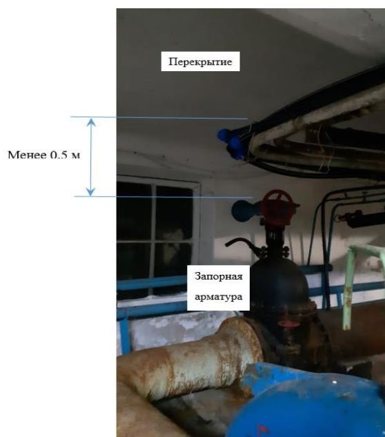
Рис. 1. Расположение запорной арматуры на трубопроводе (ВОС-1), демонтаж которой невозможен без остановки станции
